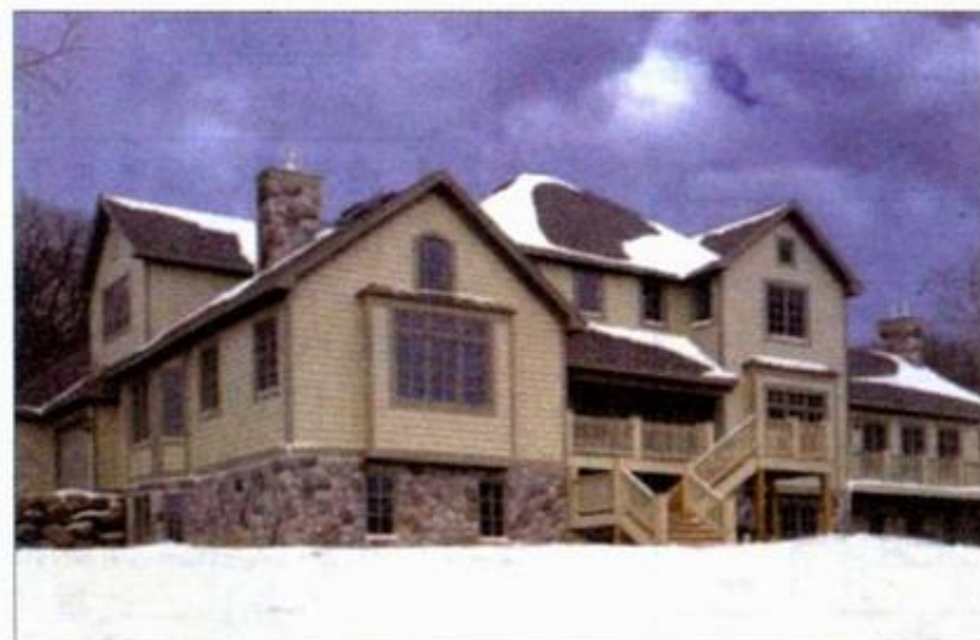
水平铺设实例
