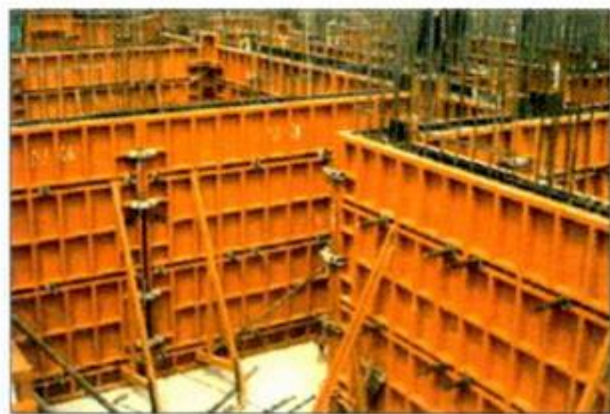
饰面混凝土模板体系
