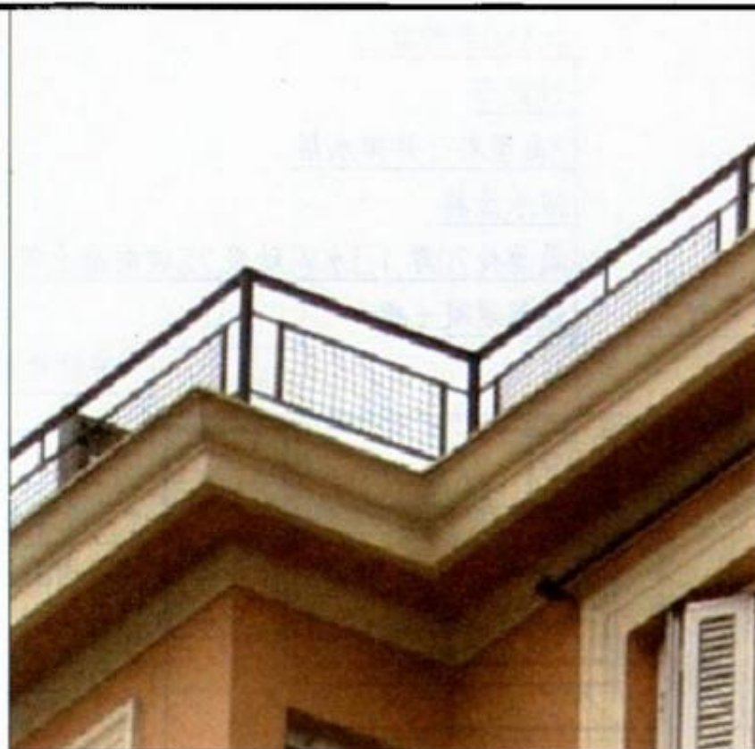
金属栏杆女儿墙
