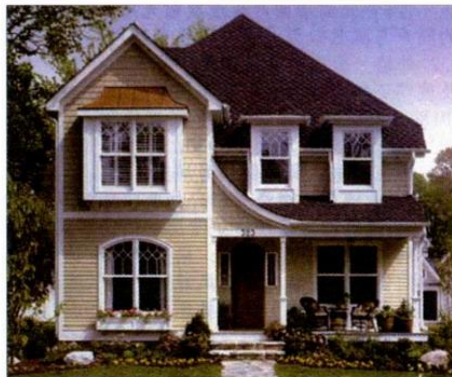
水平铺设实例
